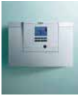
VWZ AI MB5 Otomatik arayüz kontrol paneli Sistem ve ortam parametrelerinin detaylı girildiği, otomatik arayüz kontrol paneli.
